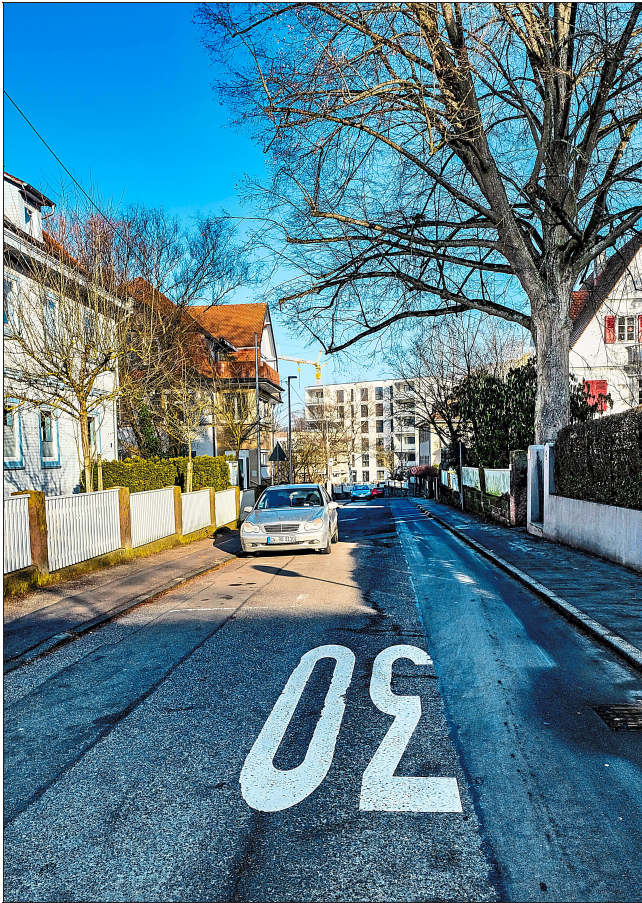
Der Technische Ausschuss der Stadt Nagold gab jetzt Mittel für die Sanierung der Wasser- und Abwasserleitungen in der Hohe Straße frei. Foto: Fritsch
