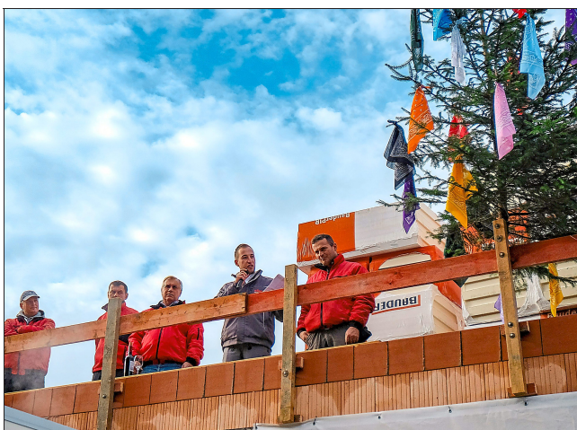
Bauleiter Daniel Lutz trägt den Richtspruch vor.
